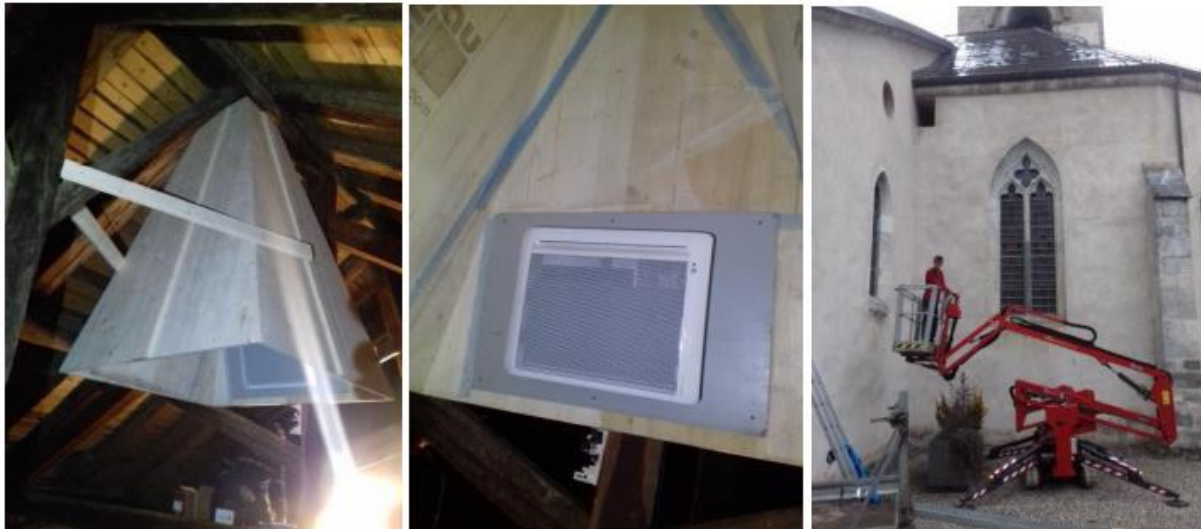
Figure 22 : Gauche : cloche thermique accrochée dans les combles de l'église du Châble. Centre : chauffage interne de la cloche ainsi que treillis d'accroche à maille très fine. Droite : l'œil de bœuf et la petite ouverture rectangulaire par lesquels les chauves-souris entrent et sortent du gîte.
